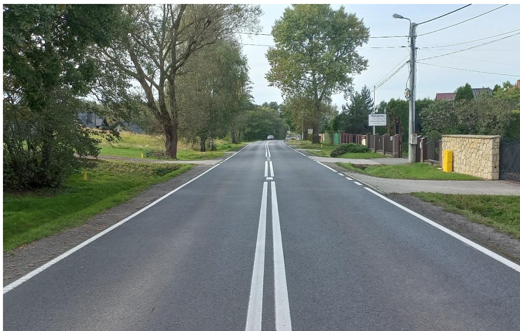
Fot. 4.9 Przekrój drogi krajowej nr 44 w miejscowości Zelczyna
