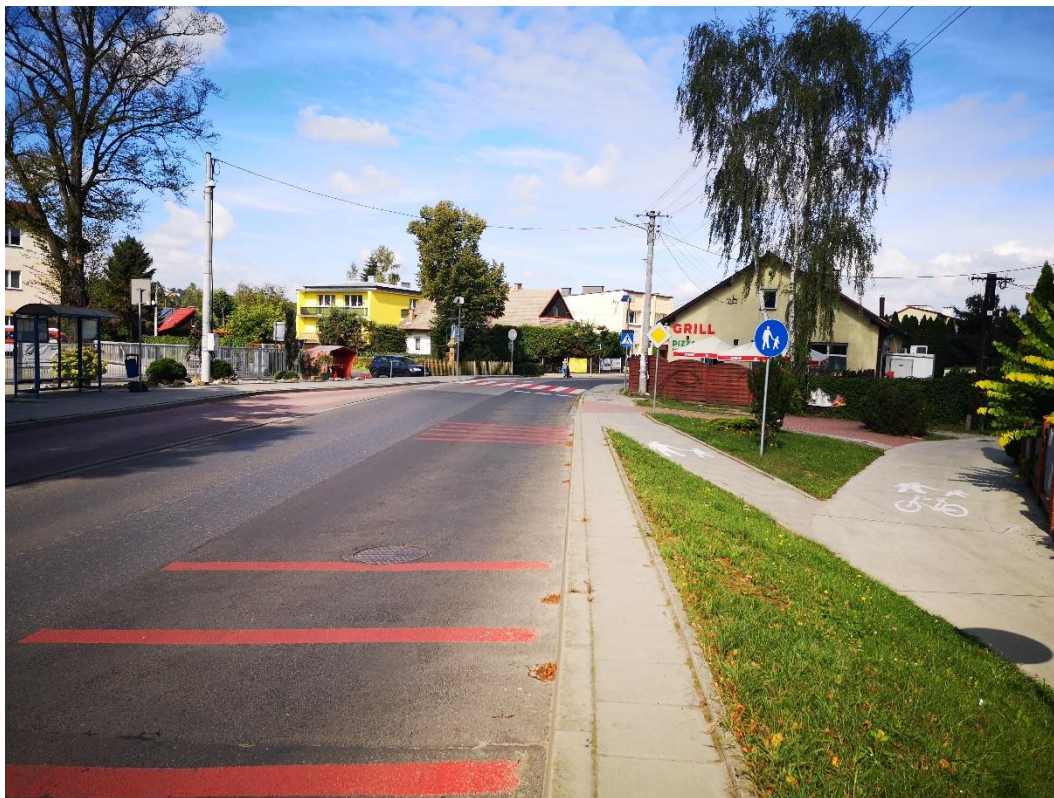
Fot. 4.8 Infrastruktura piesza w obrębie ul. Jana Pawła II w Radziszowie
