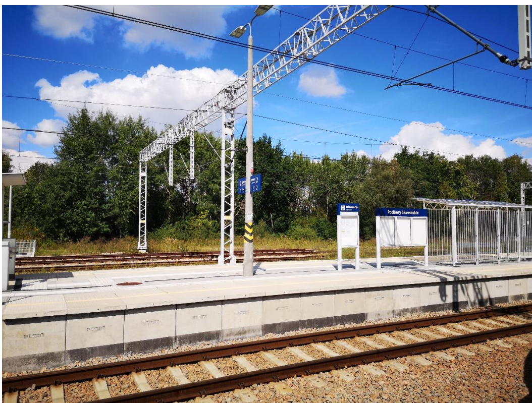
Fot. 4.6 Zmodernizowana stacja kolejowa w Podborach Skawińskich
