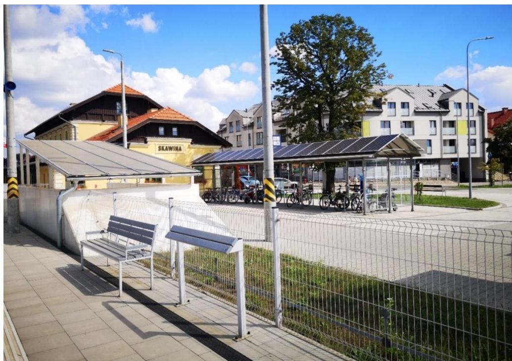
Fot. 4.12 Parking rowerowy w systemie Bike&Ride przy stacji kolejowej w Skawinie
