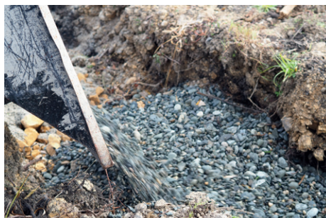
Warstwowe wypełnianie ogrodu deszczowego poszczególnymi materiałami | fot. Fundacja Sendzimira
