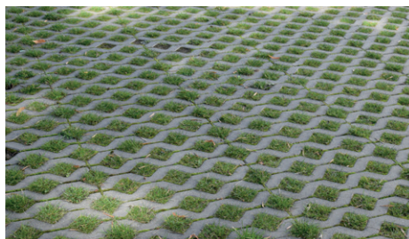
Wzmocniona nawierzchnia trawiasta | fot. Agnieszka Kowalewska, Fundacja Sendzimira
