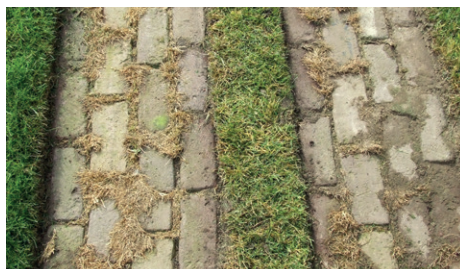
Nawierzchnia z cegły klinkierowej o podbudowie żwirowej | fot. Fundacja Sendzimira
