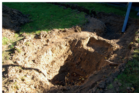
Wykop pod ogród deszczowy przy Szkole im. św. Jana Pawła II, Radziszów, 2021 r. | fot. Fundacja Sendzimira
